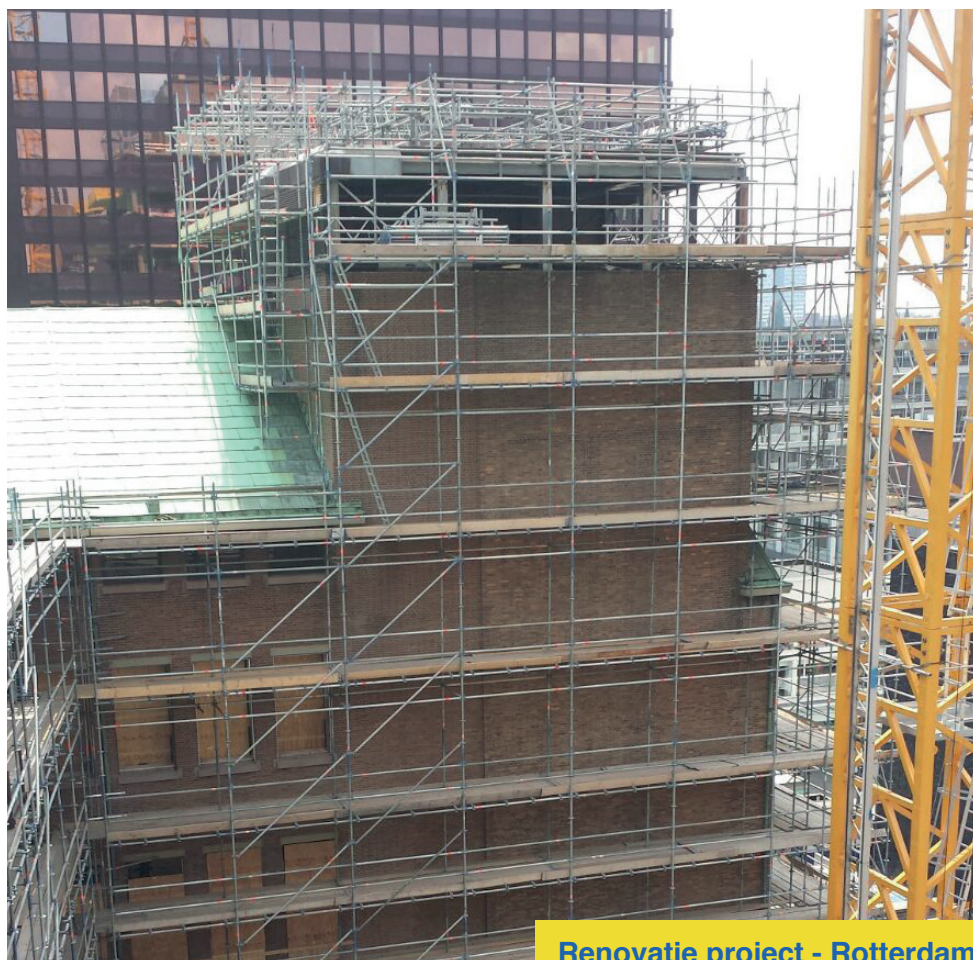
Renovatie project - Rotterdam
